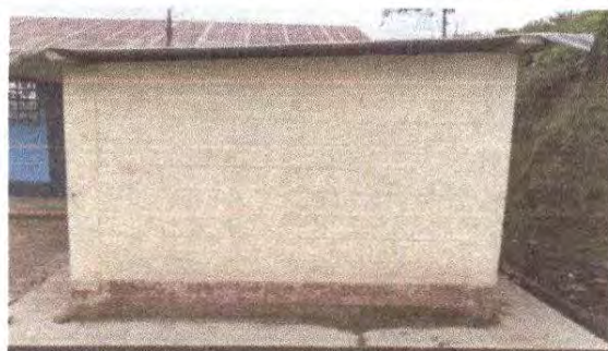
Foto 10: se pintara bodega interno y externo 4 por 2.7 altura 2.5 mts.
