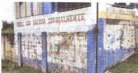
Foto 7: Pintar muro de exterior de la escuela que tiene 28 mts largo y 2.5 de alto y circulación de escuela 80 mts. Largo por 1.5 de alto mas columnas.
