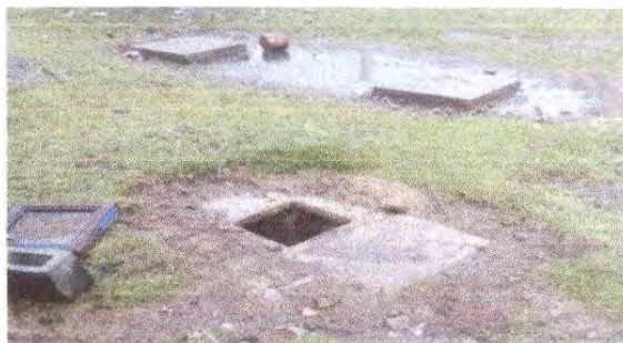
Foto 13: Limpieza de 2 fosas septicas 4mts largo por 2.5 de ancho y 4 metros de profundidad.
